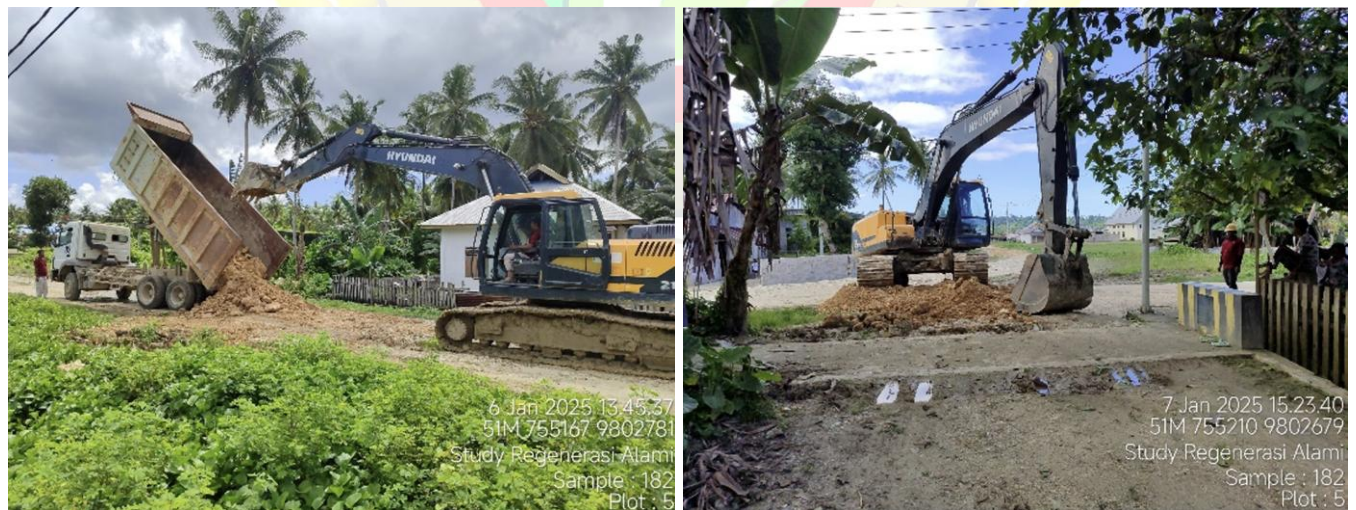
Gambar 17. Bantuan Infrastruktur Jalan Desa
